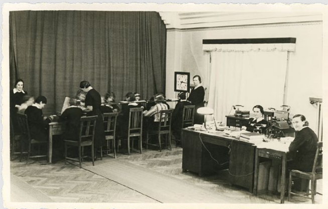
↑ Fotoatklātne. Rīgas galvenās telefonu tālsatiksmes centrāles darbinieces pie komutatoriem un darba telpā pie rakstāmgaldiem. Rīga, 1937. gada 4. februāris. Fotopapīrs, 8,5 x 13,4 cm. LNVM krājums
