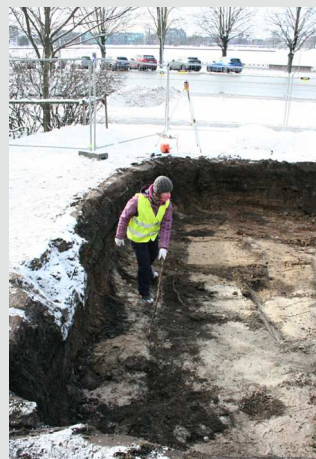
← Lietus ūdens infiltrācijas laukuma A profils, kurā redzami vairāki krastmalā pie Horna bastiona aizsargsienas sabērtie slāņi. Foto: Vitolds Muižnieks
